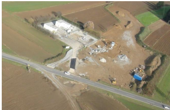
Luftaufnahme der Gasstation Frankenreith während der Bauarbeiten
